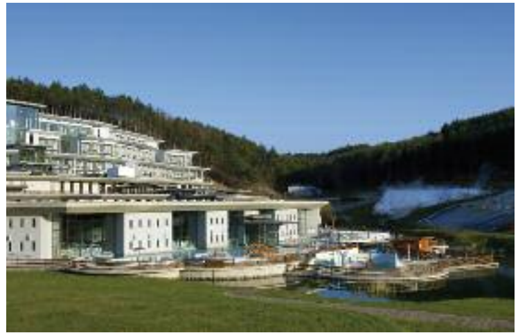
Le nouveau complexe thermal Saliris Resort.
